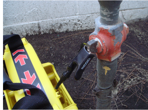
Şekil 7 – Kablo ucu hedef kondüktöre klipsle takılı
