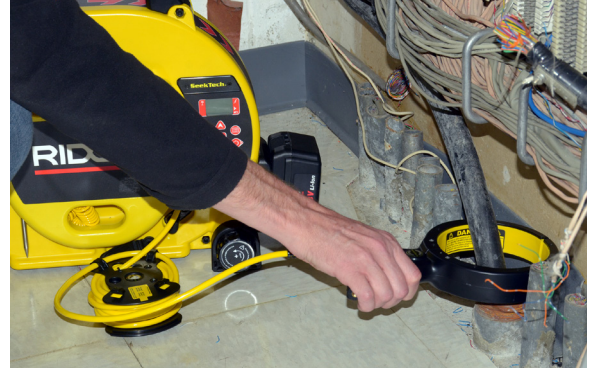
Şekil 11 – İndüktif Kıskaç kullanımında
