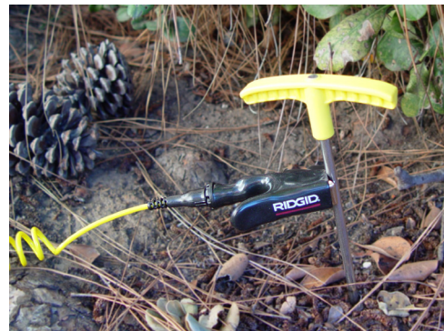
Figura 6 – Clipe do cabo preso à haste de aterramento
