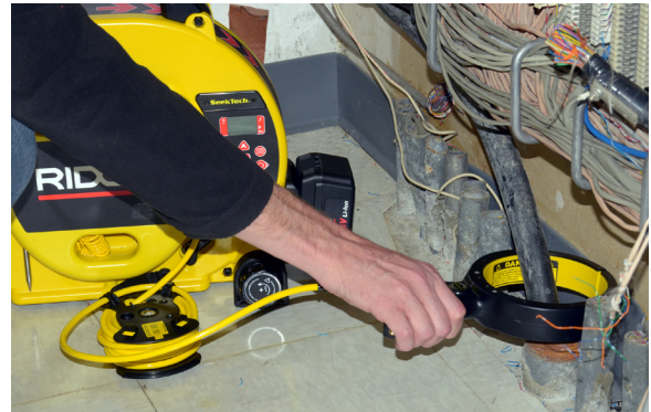
Figur 11 – Induktiv klemme i bruk
