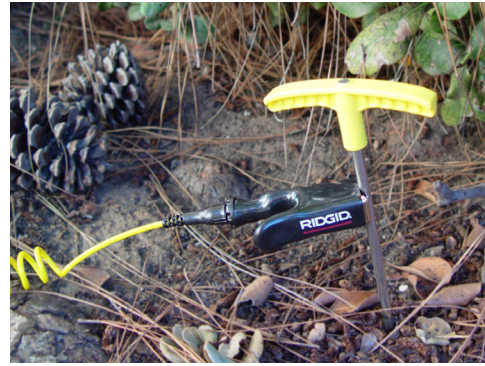
Figur 6 – Ledningsklemme koblet til jordingsstaken
