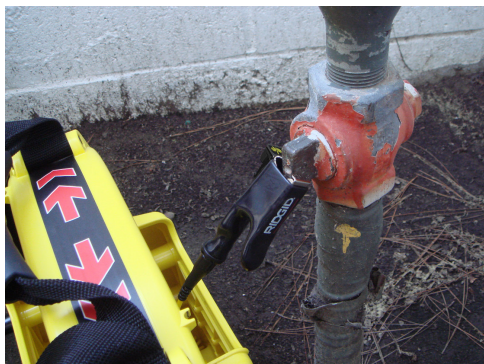
Afbeelding 7 – Kabelverbinding op doelgeleider geklemd
