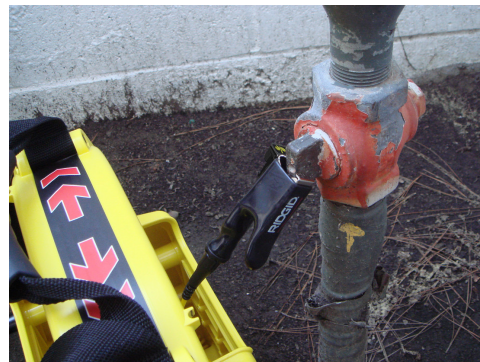
Figure 7 – Câble branché au conducteur cible
