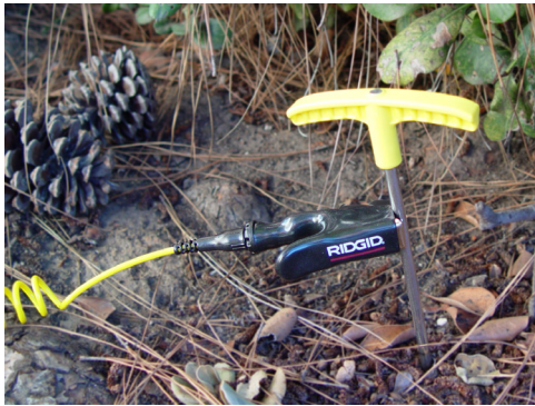
Kuva 6 – Johdon puristin kiinnitetty maapaaluun
