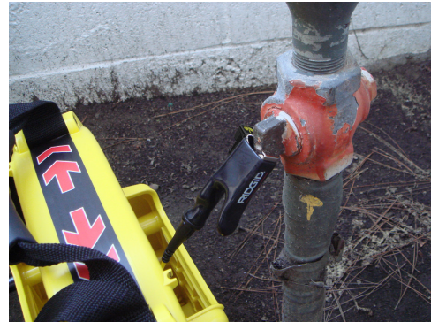
Kuva 7 – Kaapelijohto puristettu kohdejohtimeen
