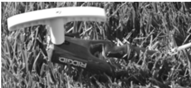
Slika 7 - Spajanje izvodnice sa štapom za uzemljenje
