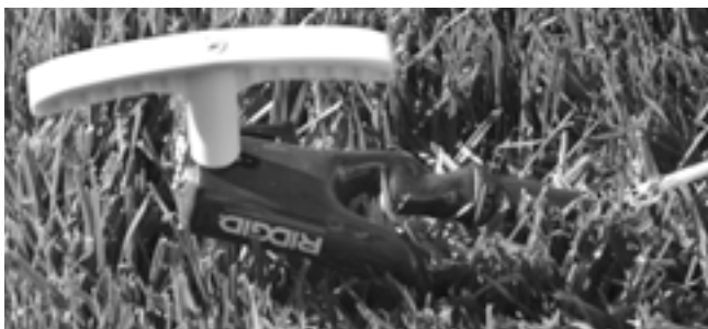
Slika 7 – Pritrditev vodnikov na ozemljitveno palico
