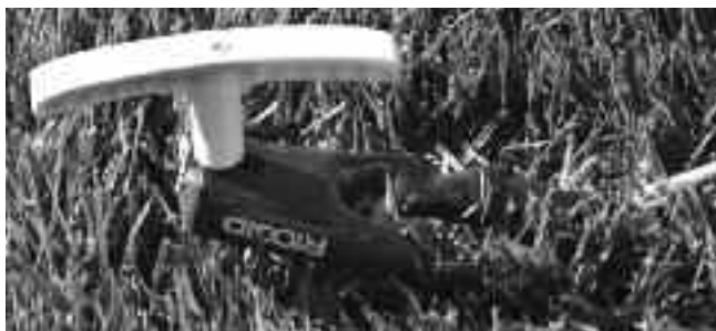
Figura 7 - Ligação do fio à estaca de ligação à terra
