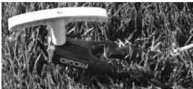
Figura 7 – Collegamento del cavo al picchetto di messa a terra
