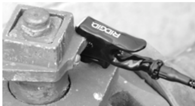
8. ábra – Kábelvezeték csatlakoztatása a vezetékhez.
