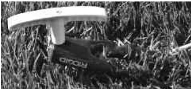
Abbildung 7 – Anschluss des Kabels an einen Erdungsstab
