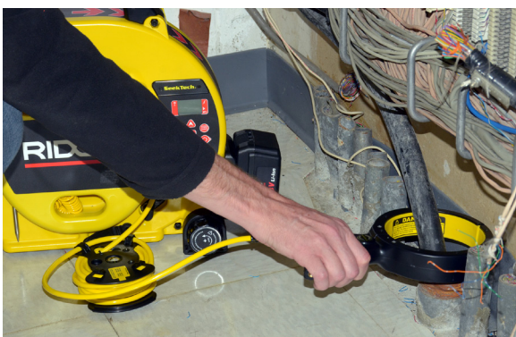
Figur 11 – Induktiv Klämma
