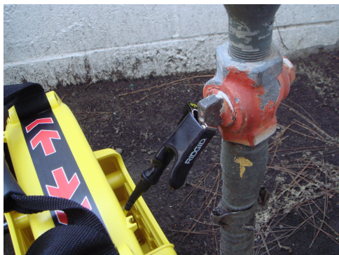
Figura 7 – Cabo preso ao condutor alvo
