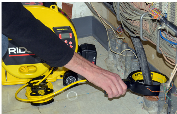
Figure 11 – Pince inductive en cours d'utilisation
