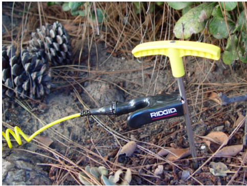
Kuva 6 – Johdon puristin kiinnitettynä maapaaluun
