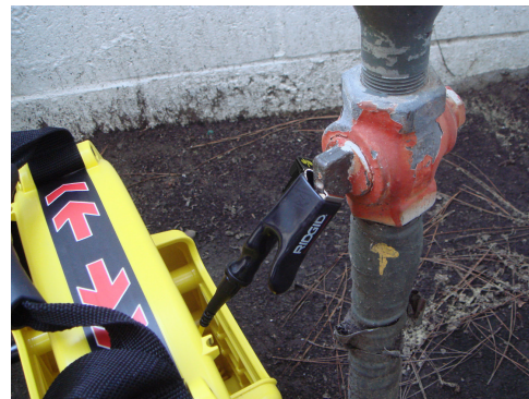
Abbildung 7 – Kabelzuführung an der Zielader angeschlossen
