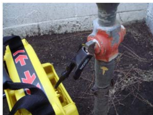
图 5-连接目标管线
