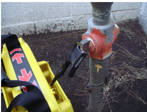
図11 - ST-33Qのケーブルリード線を対象導体に接続する
