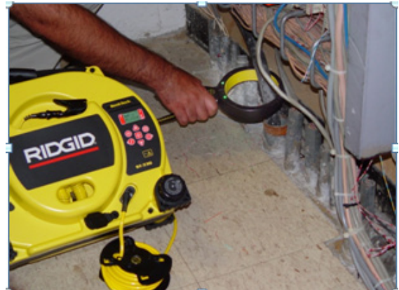
Figure 15 – Pince inductive connectée à un câble
